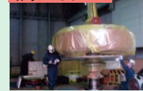
[岐阜県]長良川水力発電所
