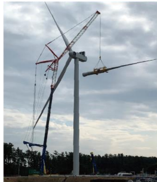
写真：ブレードつり上げ時の写真
