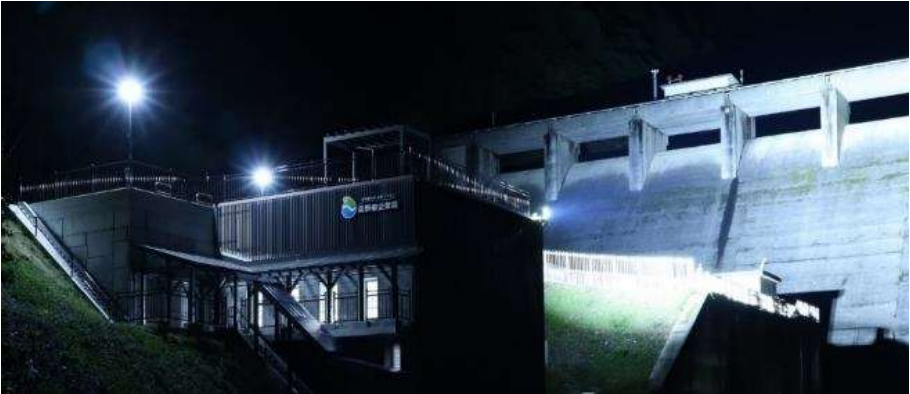
ライトアップ中の発電所
