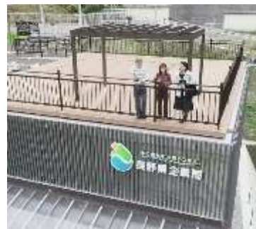
発電所/展望デッキ
