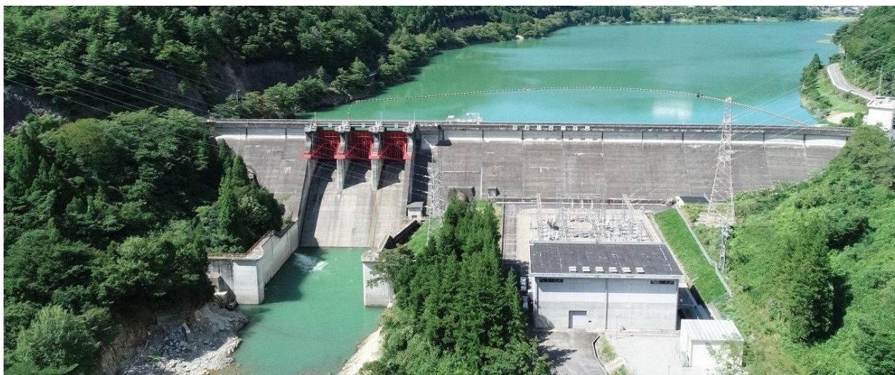
馬瀬川第二水力発電所
