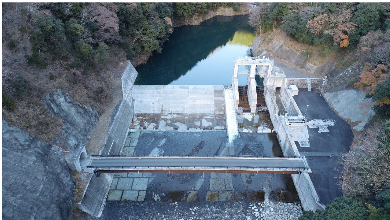
安倍川えん堤（下流から上流を望む）
