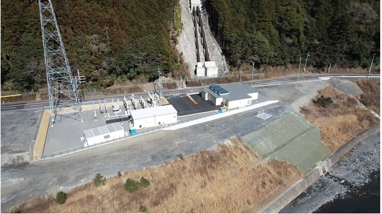
安倍川水力発電所（全景）
