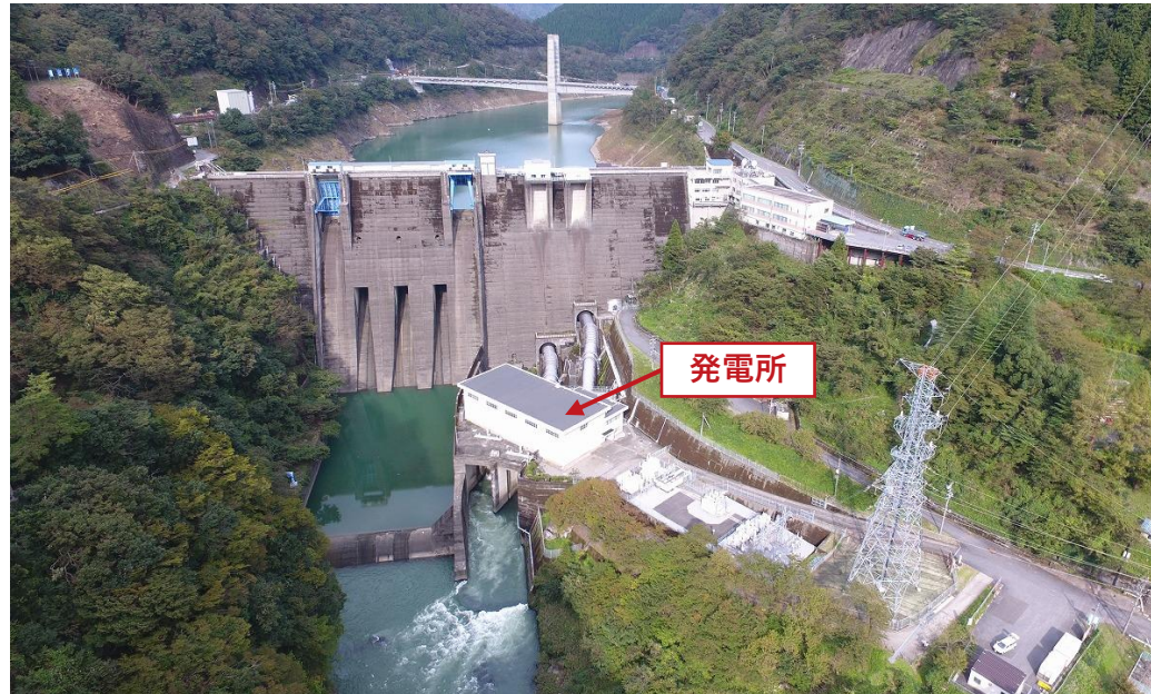
横山水力発電所
