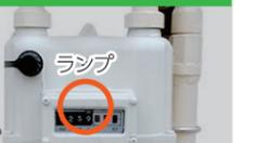
赤ランプが点滅したら、復帰ボタンのキャップを元どおりに取り付けて、約3分待ちます。赤ランプはゆっくりと点滅します。この間にマイコンメーターが安全を確認。赤ランプの点滅が消えるとガスが使えます。
