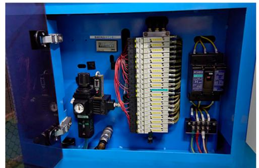
生産機器内の電磁弁（縦長のもの）。
