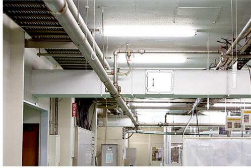
コンプレッサー室から工場内に行き渡る圧縮エアの配管
