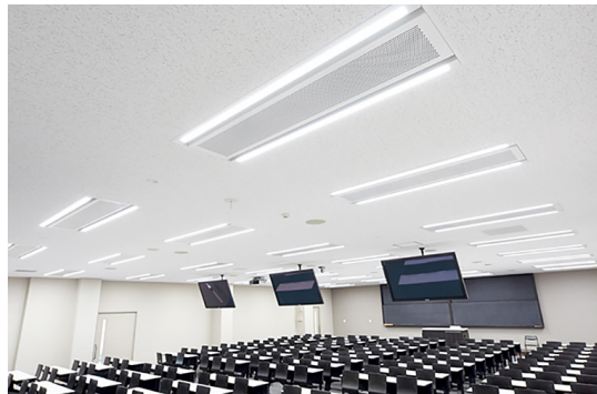
LED照明と一体化したスマートな空調室内機
