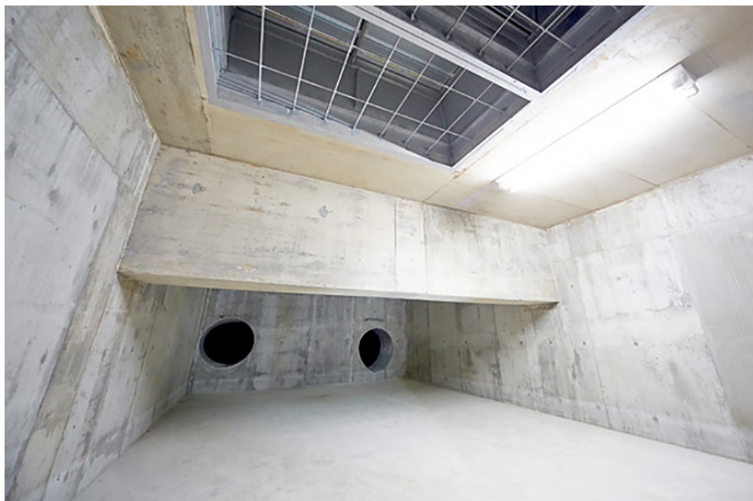
クール&ヒートピット。地中熱を利用し省エネに貢献する
