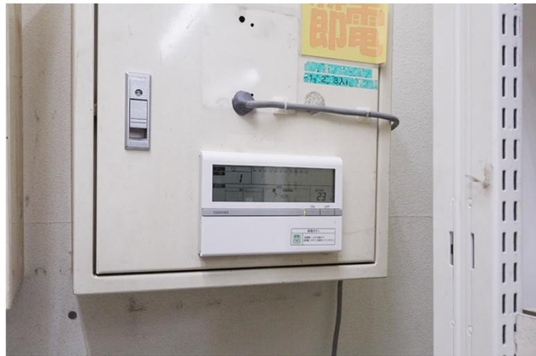
「空調管理コントローラ」から指示を受けた既設の空調集中コントローラは、現在の各空調機の運転状況を表示する。
