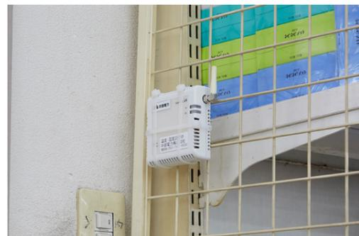
店内の温湿度分析のために各所にくまなく設置された温湿度センサ。内蔵の電池によって最長5年稼働。
