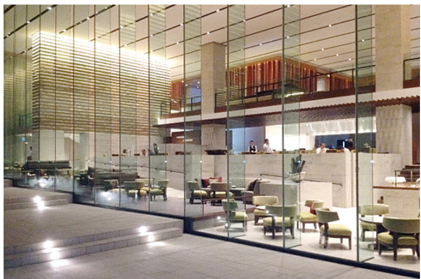
お客さまが利用する館内エリアの照明はすべてLED化
